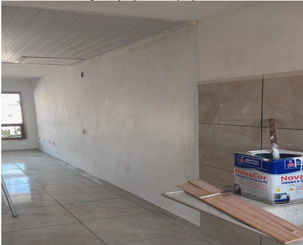
Imagem 3. Aplicação de selador para pintura final
