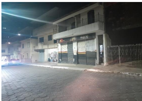
Foto 10: Rampa irregular à direita.
