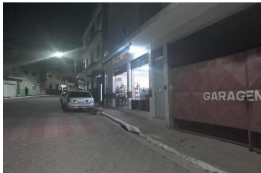
Foto 11: Inexistência de entrada acessível.
