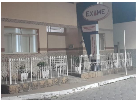
Foto 08: Comércio com entrada acessível.
