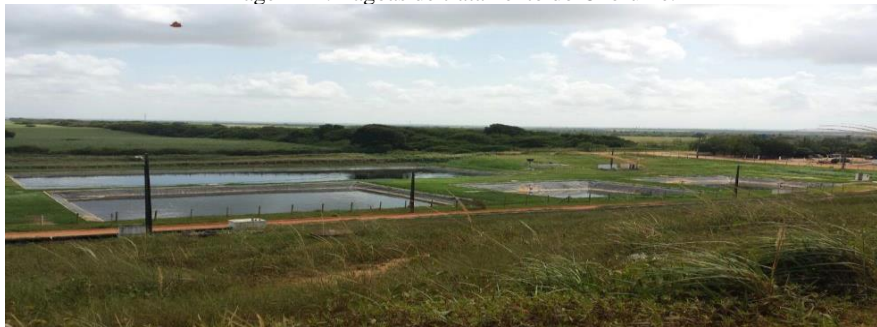
Imagem 12: Lagoas de tratamento do Chorume.
