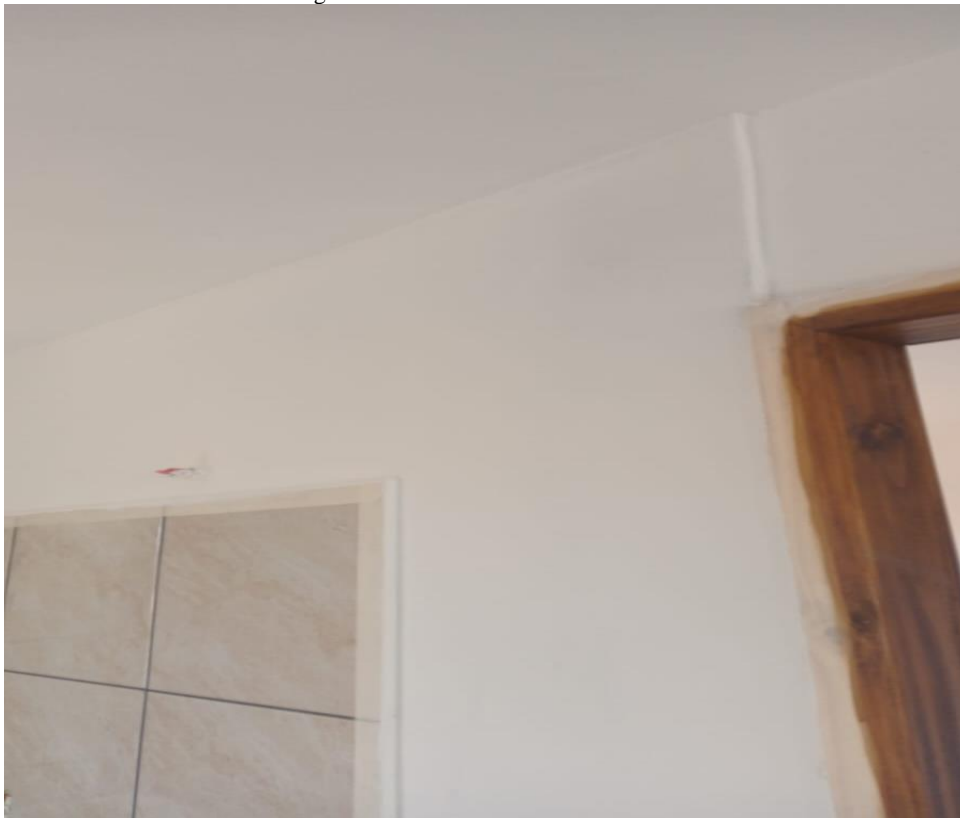
Imagem 2. Gesso com reboco convencional
