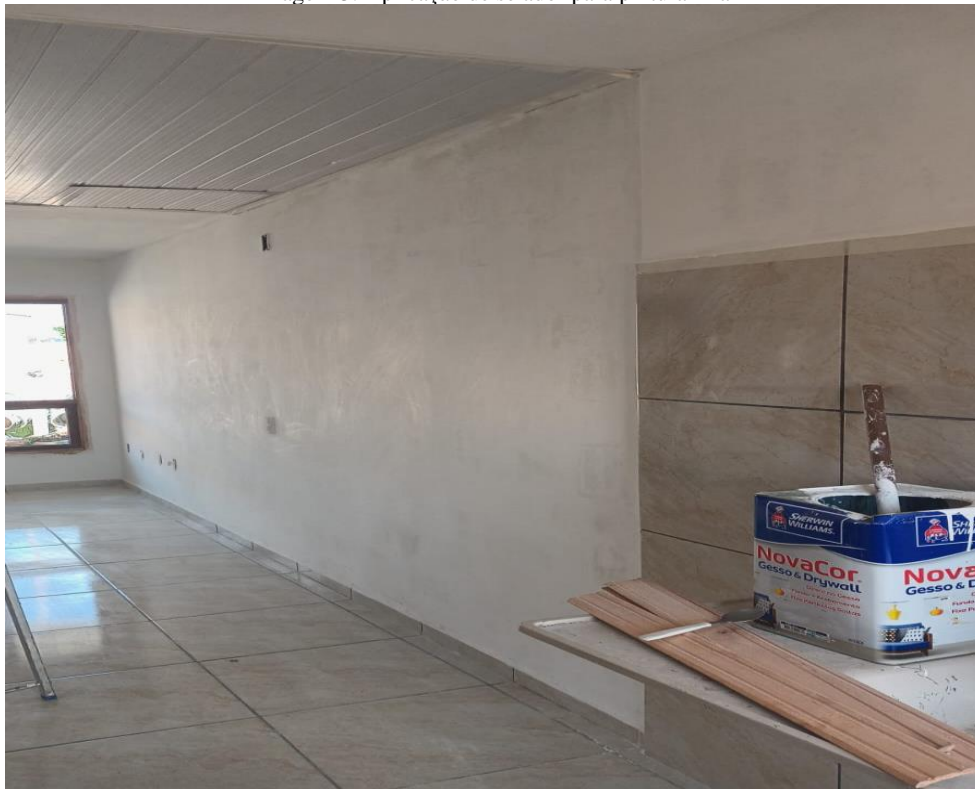
Imagem 3. Aplicação de selador para pintura final
